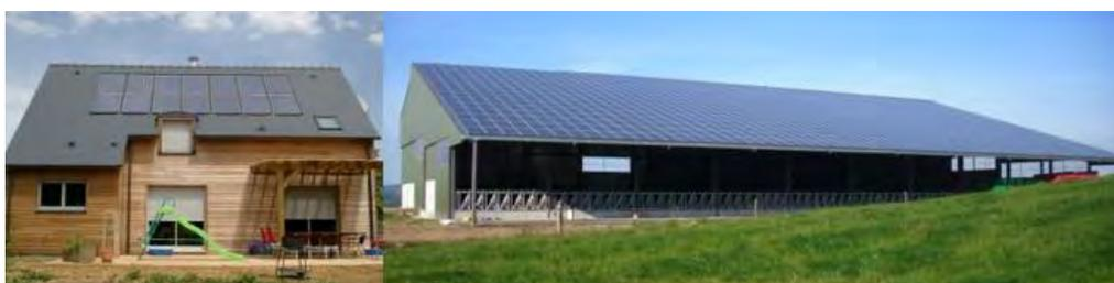
Figure 112 : Exemples de dispositifs photovoltaïques installés sur la toiture d'une maison individuelle (intégration dans la toiture en ardoise) et d'un hangar agricole (photo non prise sur le site).
